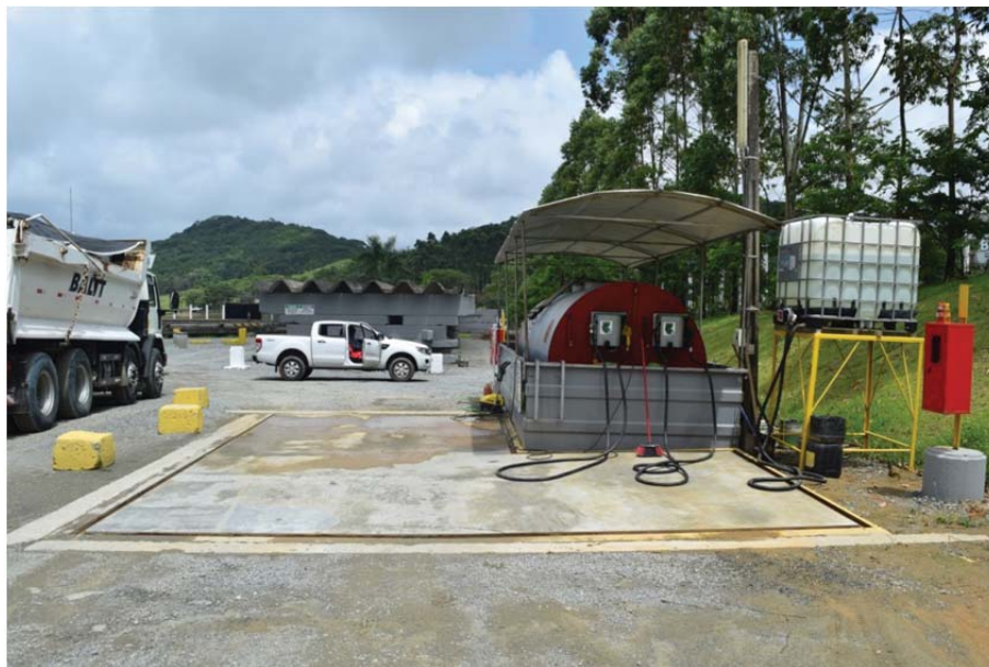
Figura 8-3: Controle dos efluentes oleosos oriundos do abastecimento de máquinas e caminhões. Fonte: do autor.
